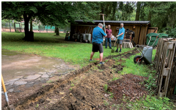
Der Graben für das Stromkabel wird ausgehoben
