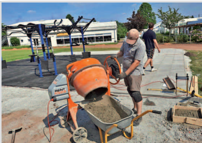
Zuerst das Fundament
