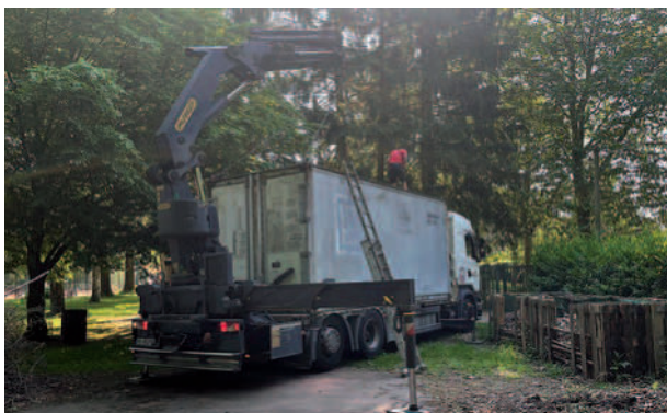
Die Anlieferung des Containers
